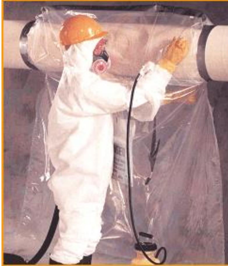
Operatore al lavoro con l'impiego di "glove bags" e aspiratore per il confinamento dinamico
